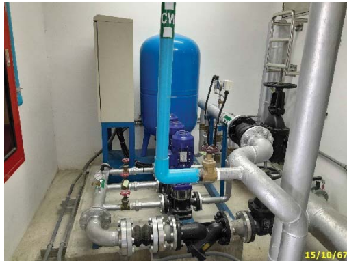
Booster Pump อาคาร X
